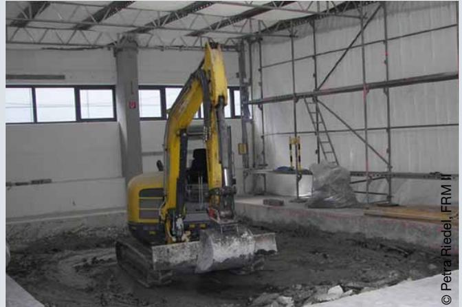
Bauarbeiten an der Forschungs-Neutronenquelle Heinz Maier-Leibnitz (FRM II): Die Messung des elektrischen Dipolmoments des Neutrons am FRM II hat extreme Anforderungen: Um magnetische Störungen am neuen Strahlplatz zu verringern, wurden auf einer Fläche von ca. 10x7m etwa 100m<sup>3</sup> Stahlbeton entfernt und durch eine nichtmagnetisch armierte und vom Gebäude getrennte Betonwanne ersetzt. Nach Ende der Bauarbeiten im Sommer können die fertigen Komponenten noch dieses Jahr installiert werden.
